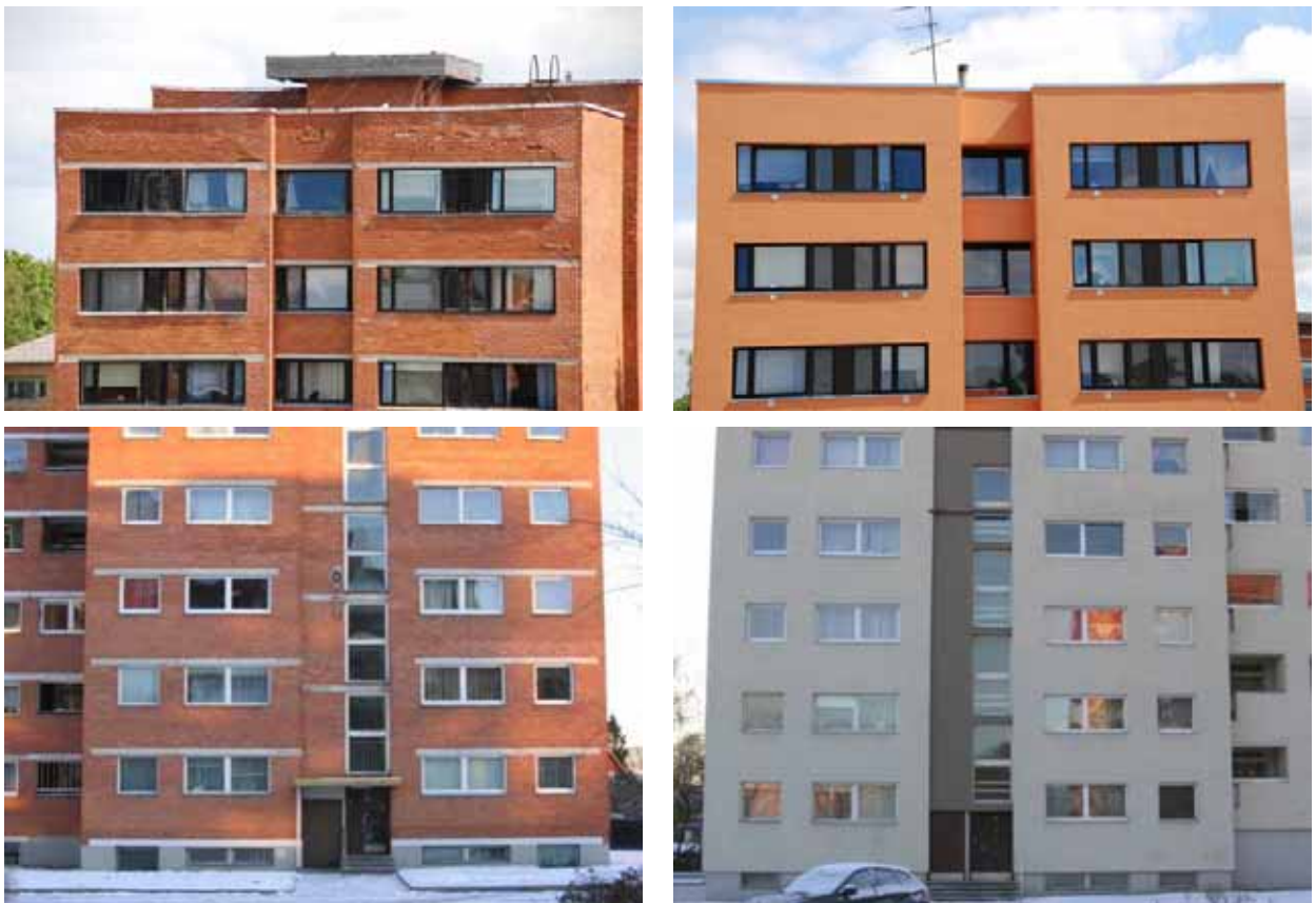
Joonis 13.9 Naaberhoonete lisasoojustamine: uus (paremal) lahendus on varasemast (vasakul) parema tehnilise ja arhitektuurse kvaliteediga.
