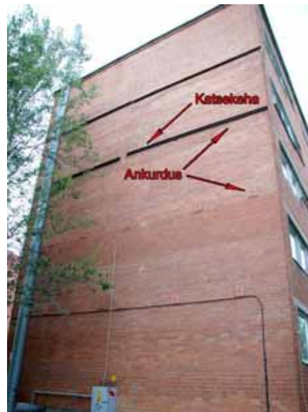
Joonis 2.4 Tellisest sidekivi on purunenud ja välisvooder on ~10 cm väljapoole liikunud (vasakul). Fassaadi sidumiseks kandva seina külge on kasutatud ankruid (paremal).
