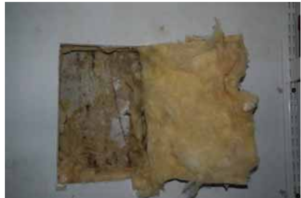
Joonis 5.33 Mõõdetud temperatuur ja suhteline niiskus lisasoojustatud seinas on soodsad hallituse tekkeks (vasakul). Seestpoolt lisasoojustatud tellissein on kaetud veeauru kondensaadiga ja hallitusega (paremal).
