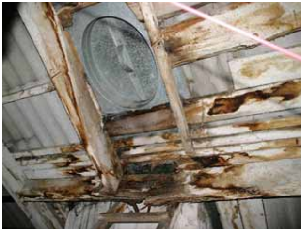
Joonis 2.25 Tüüpilised kaldkatuste läbijooksu kohad on korstnate, katuseeluukide ja teiste katusest läbiviikude juures (vasakul).
