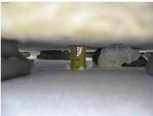
Joonis 5.10 Ebakvaliteetselt paigaldatud lisasoojustus: ei ole kasutatud soojustuse tasapinnalist liimimist ja välisõhk pääseb soojustatava seina ning soojustuse vahele.
