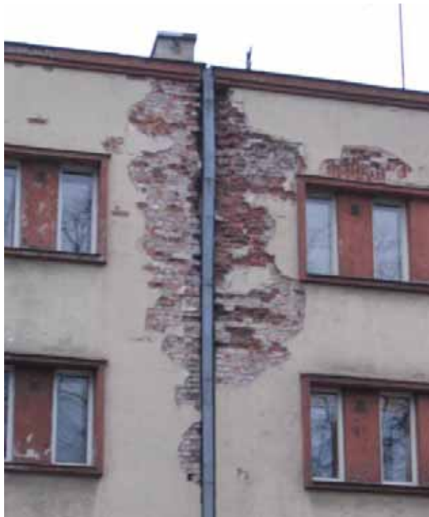
Joonis 2.11 Seinaputamine vihmaveetoru võib kõrvaldamata lekke korral suurt kahju tekitada. Külma kindlus on ammendunud ka mõned aastad tagasi asendatud tellistel (all paremal).
