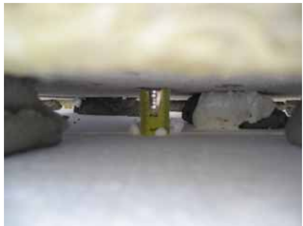
Joonis 13.5 Ebakvaliteetselt paigaldatud lisasoostus: ei ole kasutatud soojustuse tasapinnalist liimimist ja välisõhk pääseb soojustatava seina ning soojustuse vahele.
