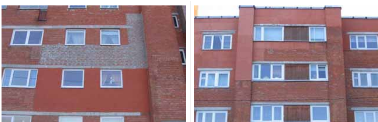
Joonis 13.7 Keraamilistest tellistest välisvooder on krohvitud, et aeglustada tema jätkuvat lagunemist.
