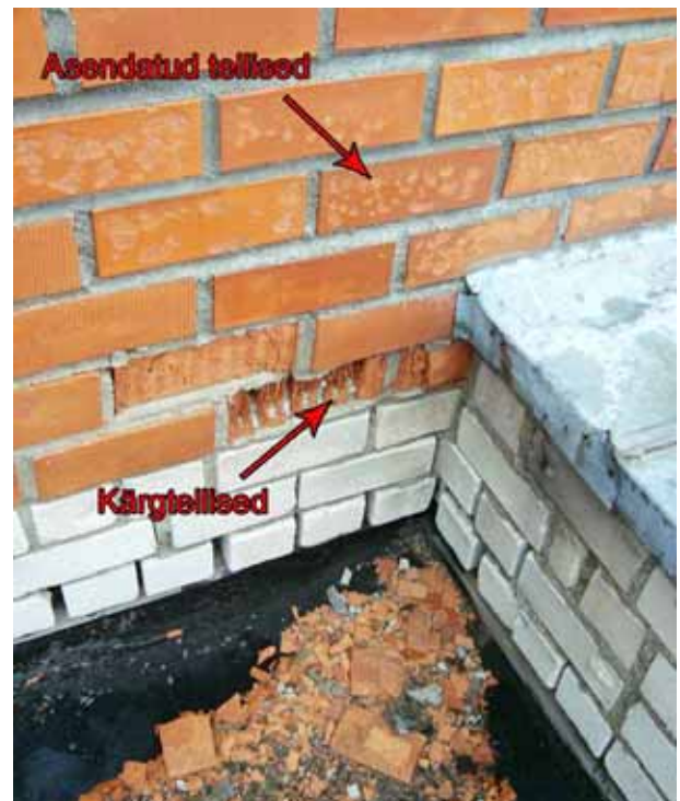
Joonis 2.11 Seinaputamine vihmaveetoru võib kõrvaldamata lekke korral suurt kahju tekitada. Külma kindlus on ammendunud ka mõned aastad tagasi asendatud tellistel (all paremal).
