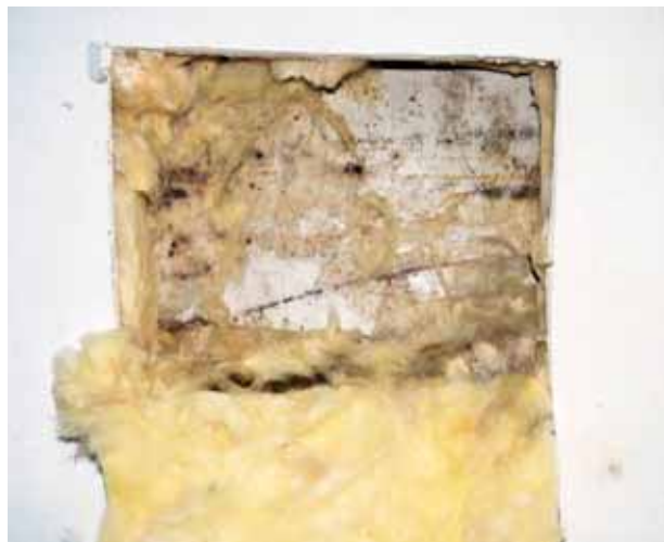
Joonis 2.22 Sisemise lisasoojustuse tõttu tekkinud hallitus vana seina sisepinnale.
