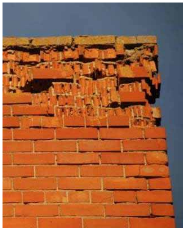
Joonis 2.12 Puudulikud katteplekid tekitavad telliste lagunemise.
