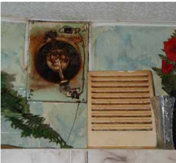
Joonis 10.5 Korterites paiknevad väljatõmbekanalitesse on aastate jooksul kogunenud mustust ja tolmu (paremal) ning ventilatsiooniseadmed on hooldamata (vasakul).
