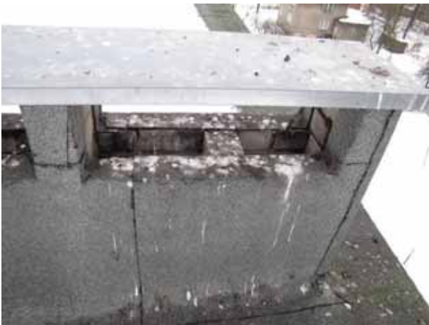
Joonis 10.4 Linnud ehitavad ventilatsioonilõõridesse pesasid ja mustavad õhukanaleid (vasakul) või kasutatakse lõõre selleks mitte ettenähtud eesmärgil (paremal).
