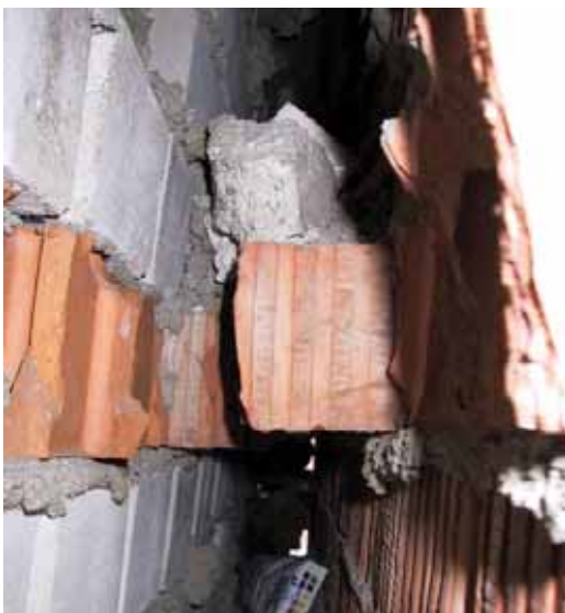
Joonis 2.5 Tellissidemete purunemise (vasakul) tagajärjeks võib olla tellisvoodri varing (paremal).
