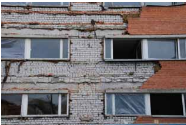
Joonis 2.15 Vanemate hoonete müüritise ladumiskvaliteet võib kohati olla väga-väga halb.
