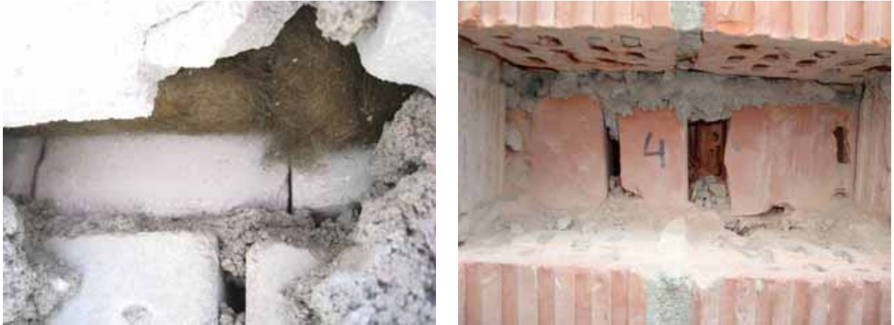
Joonis 2.16 Lohakalt laotud kandesein: mördiga täitmata püstvuugid, kaootiline seotis, üksikud kivid jne.
