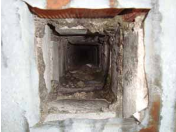
Joonis 10.3 Ventilatsioonikanalite ehitusvaliteet on halb ning seinad suure karedusega (vasakul ja paremal).
