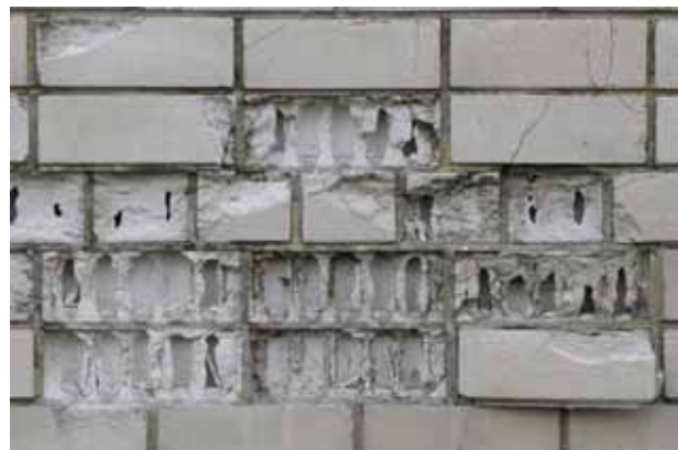
Joonis 2.6 Külmakahjustustega keraamilistest tellistest (vasakul) ja silikaattellistest (paremal) välisvooder.
