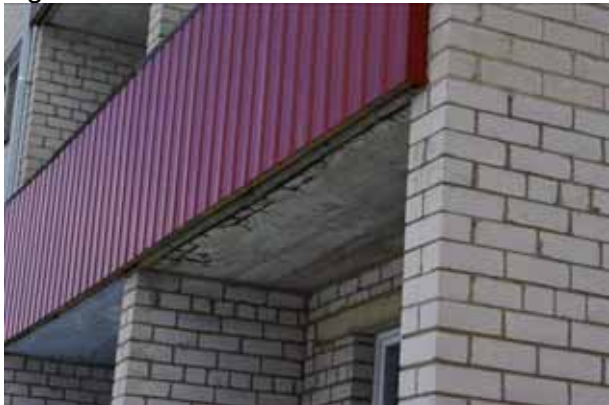
Joonis 2.29 Lagunenud lodža pörand (vasakul) ja trepikoja sissepääsu varikatus (paremal).
