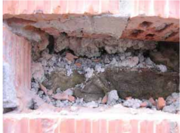
Joonis 5.9 Seina soojuslähivust suurendavad eelkõige soojustuses toimuv õhu liikumine (vasakul) ja soojustuse puudumine või selle asemel olev mört (paremal).
