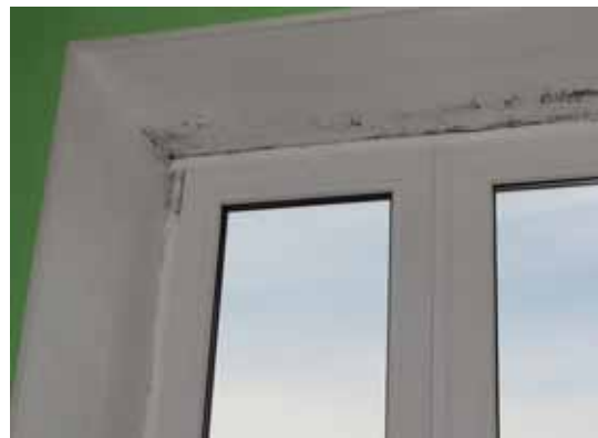
Joonis 13.2 Madalad temperatuurid (vasakul) akna ja välisseina liitekohas on põhjustanud kõrge suhtelise niiskuse, mille tagajärjeks on hallituse kasv akna ümbruses.
