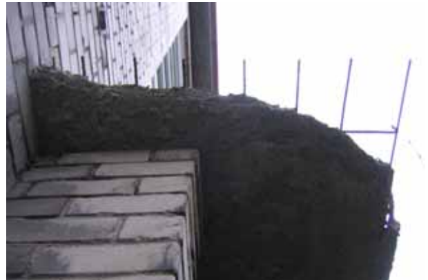
Joonis 2.29 Lagunenud lodža pörand (vasakul) ja trepikoja sissepääsu varikatus (paremal).
