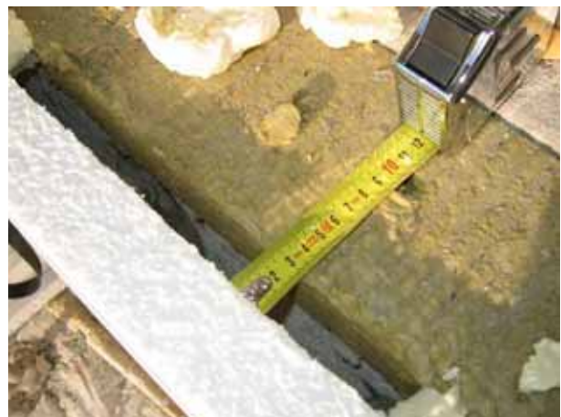
Joonis 5.10 Ebakvaliteetselt paigaldatud lisasoojustus: ei ole kasutatud soojustuse tasapinnalist liimimist ja välisõhk pääseb soojustatava seina ning soojustuse vahele.
