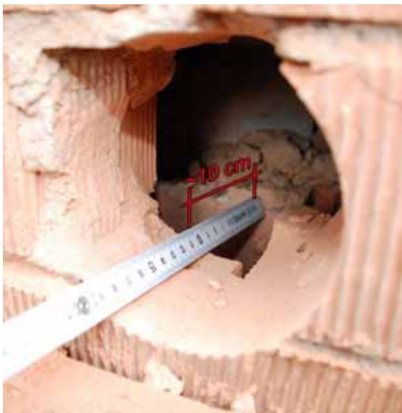
Joonis 2.4 Tellisest sidekivi on purunenud ja välisvooder on ~10 cm väljapoole liikunud (vasakul). Fassaadi sidumiseks kandva seina külge on kasutatud ankruid (paremal).
