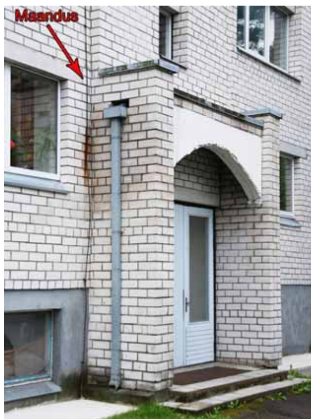
Joonis 2.13 Mõõda kaableid fassaadile sattuv vesi põhjustab telliste lagunemise.
