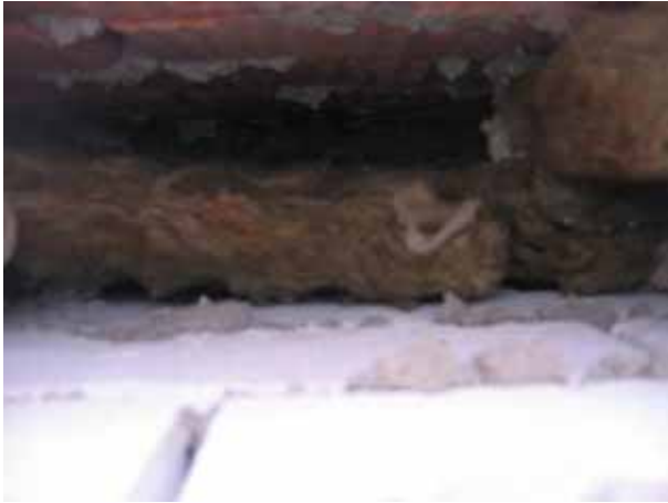
Joonis 5.9 Seina soojuslähivust suurendavad eelkõige soojustuses toimuv õhu liikumine (vasakul) ja soojustuse puudumine või selle asemel olev mört (paremal).
