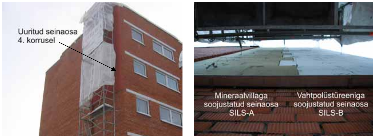
Joonis 5.11 Uuritud seinosa asus 4. korrusel (vasakul). Korstnapoolne e. vasakpoolne seinosa oli soojustatud mineraalvillaga e. SILS-A; nurgapoolne e. parempoolne seinosa oli soojustatud vahtpolüstüreeniga e. SILS B (paremal, foto on tehtud sein tasapinnas, alt üles).
