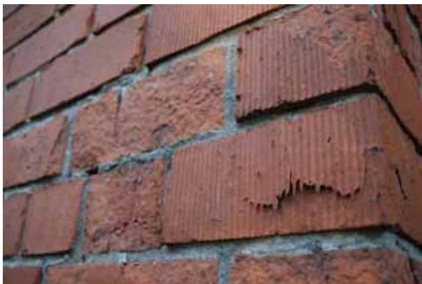
Joonis 2.6 Külmakahjustustega keraamilistest tellistest (vasakul) ja silikaattellistest (paremal) välisvooder.
