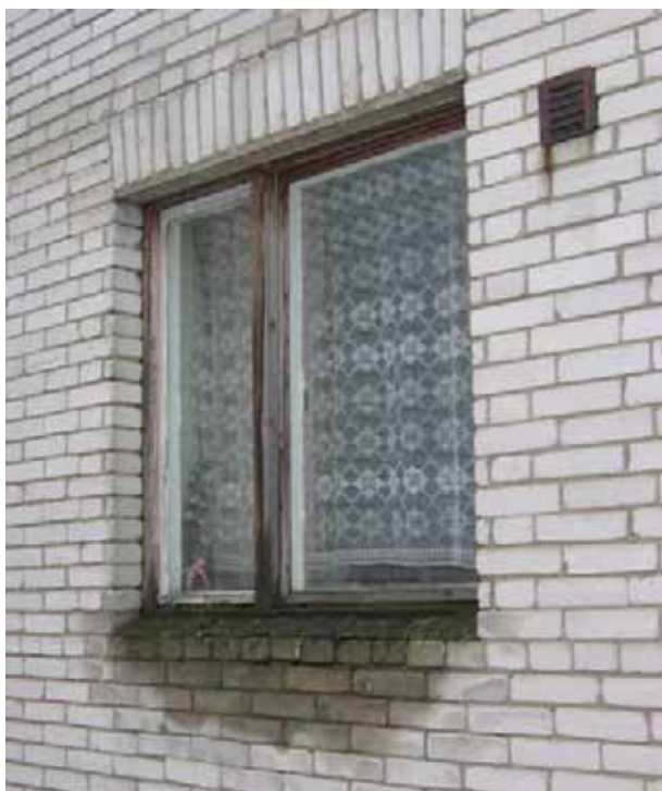
Joonis 2.12 Puudulikud katteplekid tekitavad telliste lagunemise.
