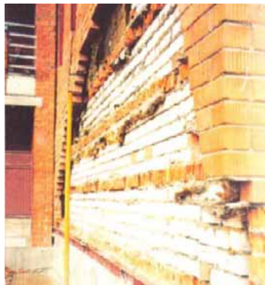
Joonis 2.5 Tellissidemete purunemise (vasakul) tagajärjeks võib olla tellisvoodri varing (paremal).
