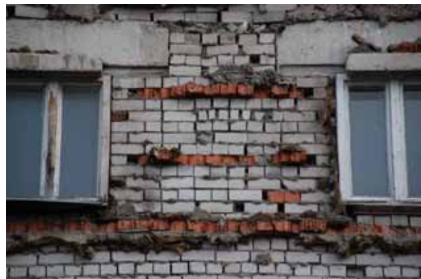
Joonis 2.15 Vanemate hoonete müüritise ladumiskvaliteet võib kohati olla väga-väga halb.
