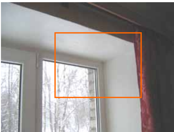
Joonis 3.5 Lodža liitumine välisseinaga.
