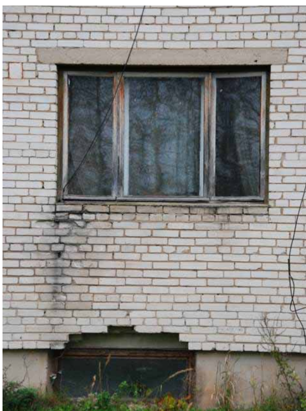
Joonis 2.13 Mõõda kaableid fassaadile sattuv vesi põhjustab telliste lagunemise.
