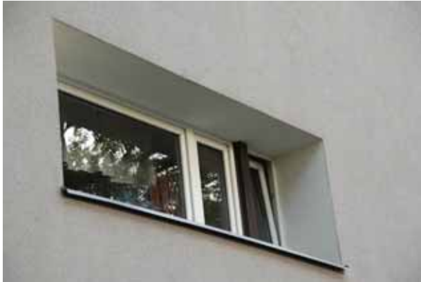
Joonis 13.10 Vältimaks välisseinte lisasoostamisel akende „auku“ jäämist tuleks aknad tõsta olemasoleva välisseina välispinda.
