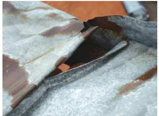
Joonis 2.25 Tüüpilised kaldkatuste läbijooksu kohad on korstnate, katuseeluukide ja teiste katusest läbiviikude juures (vasakul).
