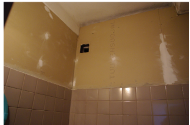
Joonis 10.7 Pliidikubude ühendused on tehtud ebatihedalt (vasakul) ja väljatõmbe lõppelemendid on eemaldatud (paremal)
