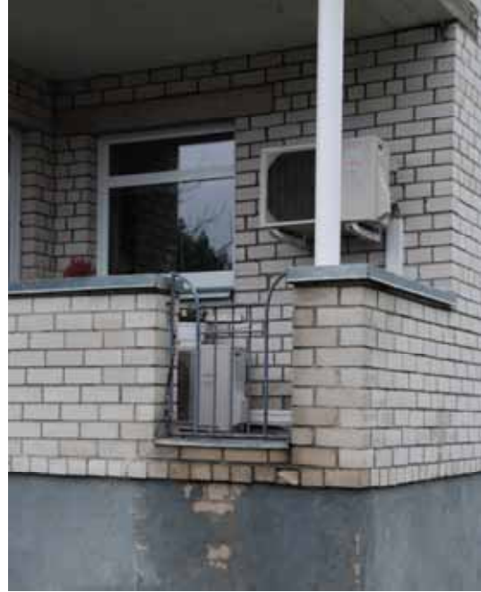
Joonis 10.8 Korteri paiknev lokaalne gaasikatel või soojuspump ruumide kütteks ja/või tarbevee soojendamiseks.
