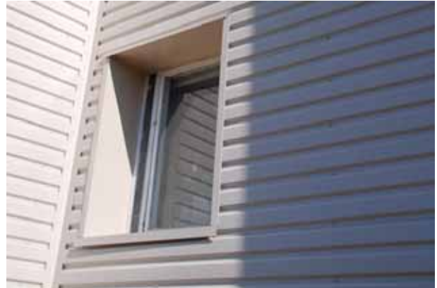
Joonis 13.10 Vältimaks välisseinte lisasoostamisel akende „auku“ jäämist tuleks aknad tõsta olemasoleva välisseina välispinda.
