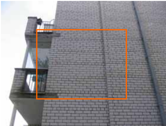
Joonis 3.8 Sidekiviread välisseinas.
