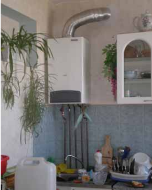
Joonis 10.8 Korteri paiknev lokaalne gaasikatel või soojuspump ruumide kütteks ja/või tarbevee soojendamiseks.
