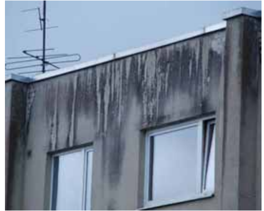
Joonis 2.26 Katuse lekke (vasakul) ja katuselt seinale langenud vee tõttu kahjustunud ülemise korruse välisseinad.
