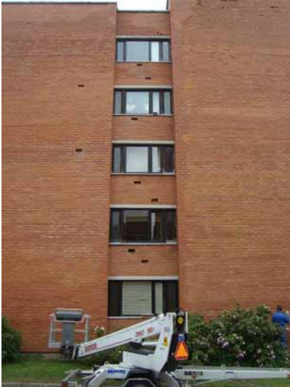
Joonis 2.8 Telliste valik ja eemaldamine fassaadist.
