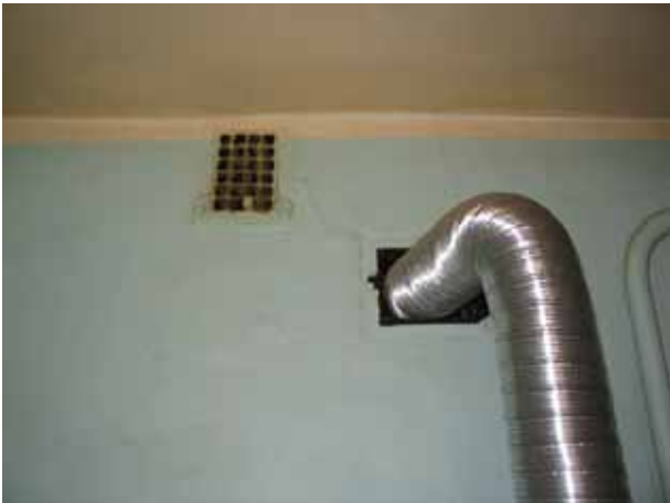
Joonis 10.7 Pliidikubude ühendused on tehtud ebatihedalt (vasakul) ja väljatõmbe lõppelemendid on eemaldatud (paremal)
