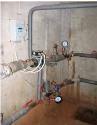
Joonis 10.9 Keldris paiknevate küttetorude puudulik soojustus.
