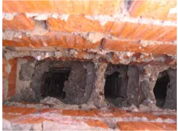
Joonis 10.3 Ventilatsioonikanalite ehitusvaliteet on halb ning seinad suure karedusega (vasakul ja paremal).
