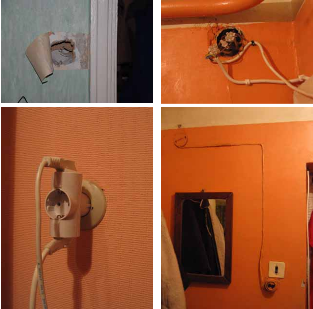
Joonis 10.11 Lahtiseid elektrikaableid korteris (üleväl) ja pistikupesade ülekoormamine (all) on elektriõhutus silmas pidades väga riskantsed.
