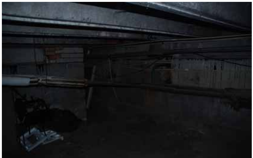
Joonis 10.9 Keldris paiknevate küttetorude puudulik soojustus.
