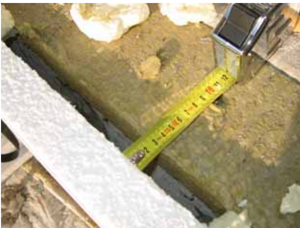
Joonis 13.5 Ebakvaliteetselt paigaldatud lisasoostus: ei ole kasutatud soojustuse tasapinnalist liimimist ja välisõhk pääseb soojustatava seina ning soojustuse vahele.
