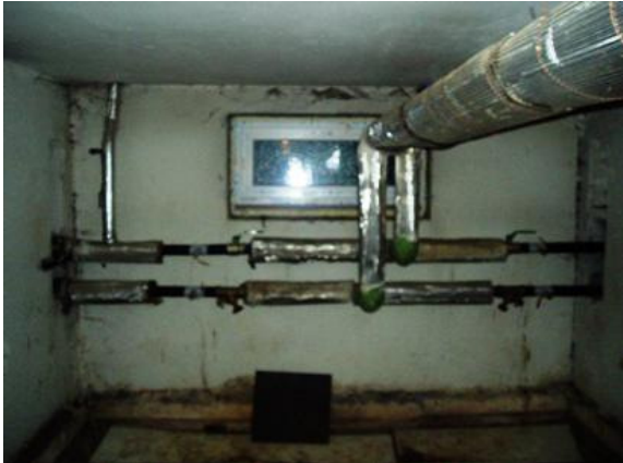
Joonis 3.11. Küttetorustik keldris enne (vasakul) ja pärast renoveerimist (paremal).
