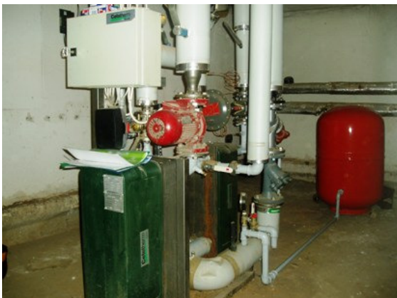
Joonis 3.12. Soojussõlm enne (vasakul) ja pärast renoveerimist (paremal).
