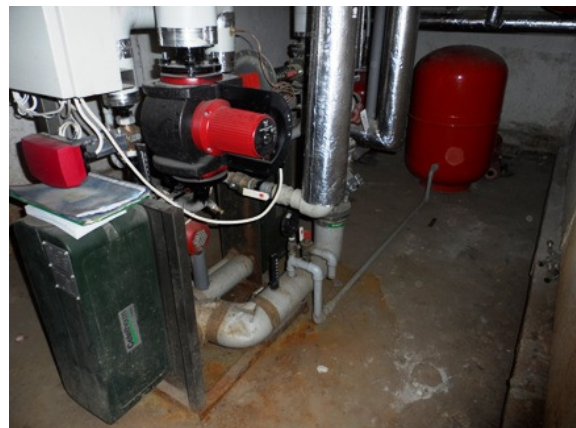
Joonis 3.12. Soojussõlm enne (vasakul) ja pärast renoveerimist (paremal).
