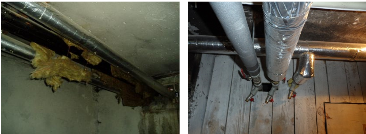
Joonis 3.19. Veetorustik enne (vasakul) ja pärast renoveerimist (paremal).
